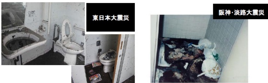
水が流れないトイレを使用したら、あっという間に便器内は大小便の山になってしまう。 東日本大震災で津波被害に遭った地域ではこのようなトイレが数多く見られ、到底使用出来る状況ではなかった。
